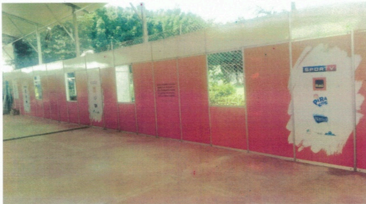
Foto do Fachada Interno/Túnel para Área de Campos
